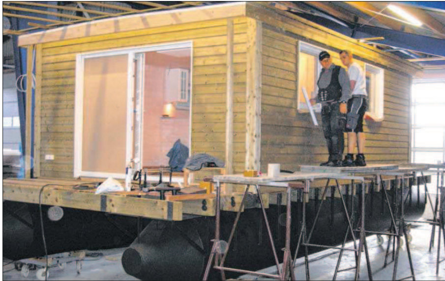
Zimmermann Roland Gardt (47, li.) und Mitarbeiter Benjamin Bausch (28) bauen eine schwimmende Ferienwohnung für ein Ehepaar aus Lübeck. Die zwei Schwimmkörper aus Stahl halten später das bis zu 12,5 Tonnen schwere Hausboot über Wasser. Fotos: Stern Hausboot (1), Ulbrich
